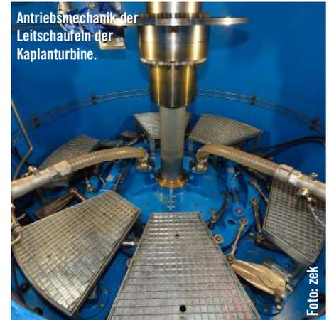
Antriebsmechanik der Leitschaufeln der Kaplanmaschine.
