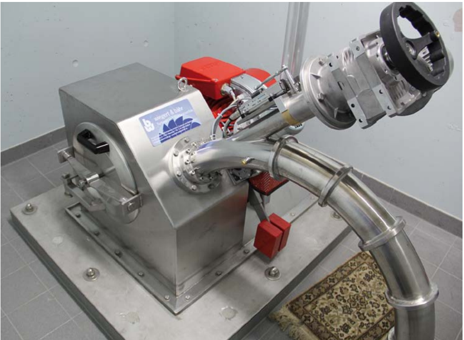
Abb. 3: Wasserwerk Stadtwerke Bühl: 1-düsige Pelton-Turbine, Leistung 22 kW, in Kompaktausführung
