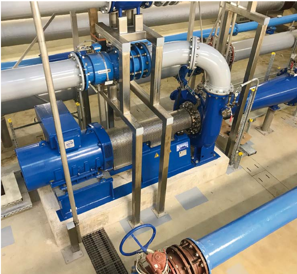
Abb. 9: Thüringer Fernwasserversorgung; Anlage Gotha mit einer Francis-Turbine, Leistung 260 kW
